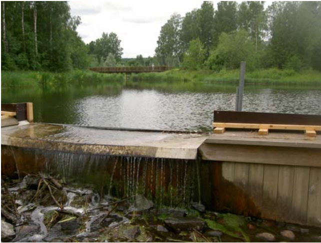
Bild 5. Utlopp dagvattendamm.
