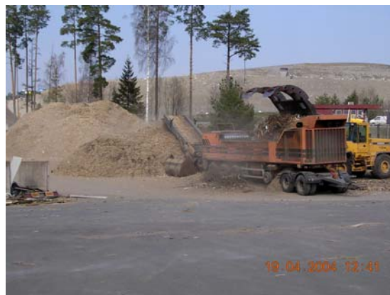
Krossning av virkesavfall från byggen. Efter fragmentering kan virket lätt självantända. Vid besöket hade man nyligen haft en brand. Det fragmenterade virket bör därför helst inte mellanlagras före förbränning. Idag är det nödvändigt eftersom både tillgång och efterfrågan är ojämn.
