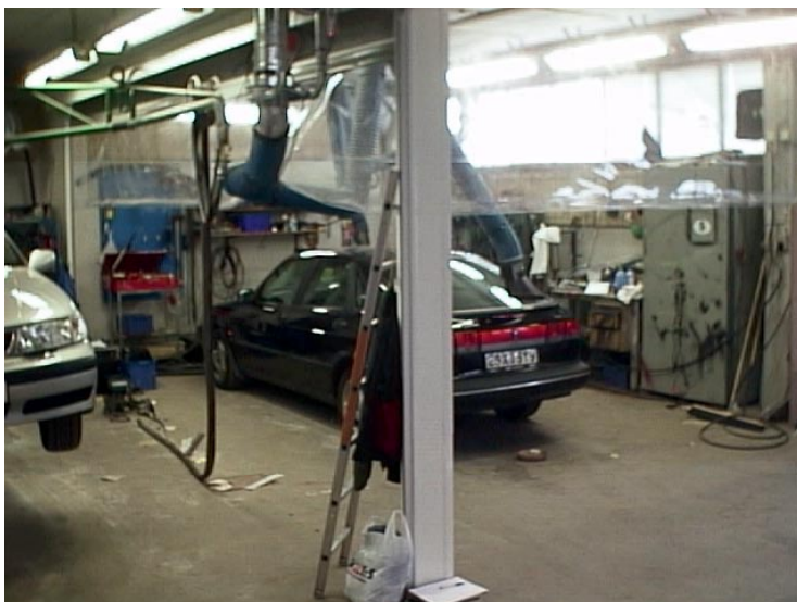
Bild 19. Exempel på en draghuv byggd i plastfolie.
