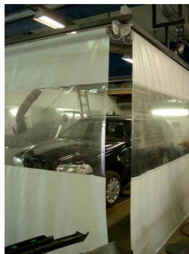
Bild 15. Övre raden vänster. Aluminiumramade genomsynliga plastväggar med nerrullningsbar öppning.
