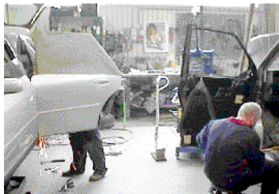
Bild 2. Spridningsmätning. Svetsning pågår bakom dörren till vänster samtidigt som en annan person arbetar på angränsande bil. Spridningsmätningen närmast det heta arbetet ses mellan bilarna.
