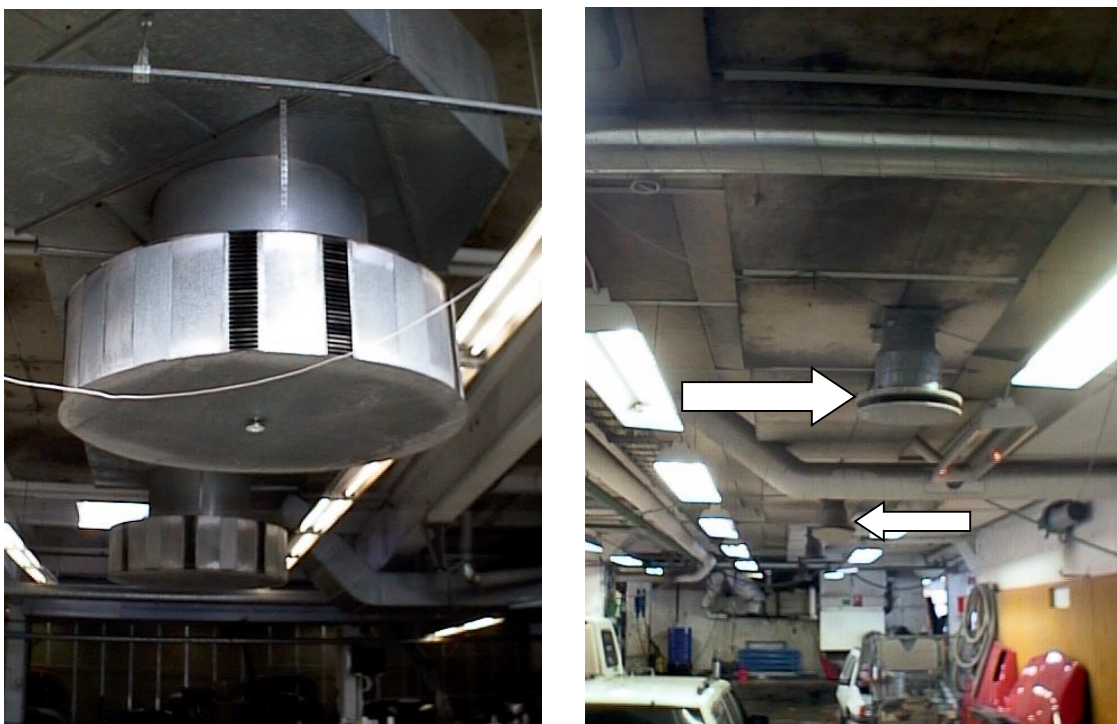
Bild 10 och 11. Exempel på tilluftsdon för omblandande ventilation. Få stora centralt placerade eller flera små (vid pilarna).
