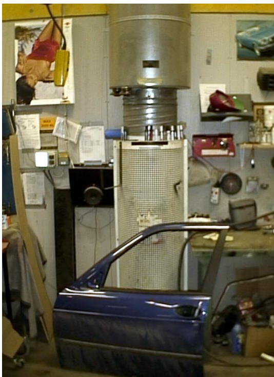
Bild 12. Tillförsel av undertempererad luft. Eftersom luften är kallare än lokalluften upplever arbetstagarna ofta luften som "dragig" nära donen. Här ses en vanlig form av "åtgärd" mot draget – en slags skärm (i detta fall bildörr) blockerar luftflödet från tilluftsdonet. I värsta fall skapar denna typ av åtgärd ännu mer dragproblem.
