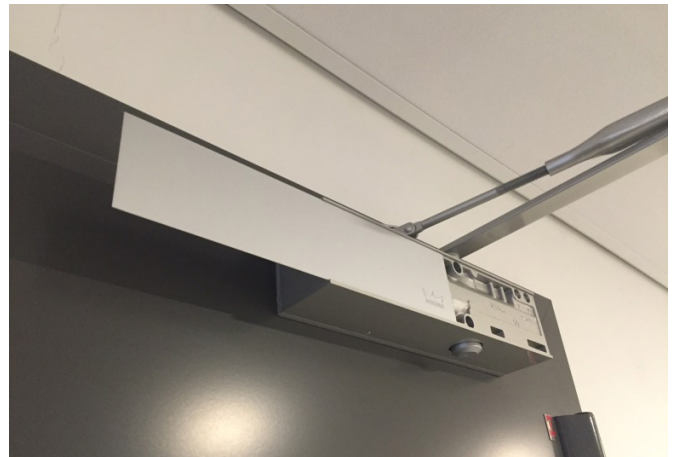
Bild 2. Dörrstängare inklusive täckplåt.
