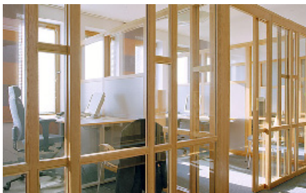
1. Vägg- och tak. Rena glaspartier och glaspartier med karm, men även akustikskivor.
