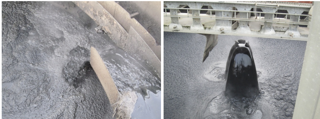
Figur 2. (a) Rundpumpning av slam; och (b) inpumpningen av slam i bassängen.
