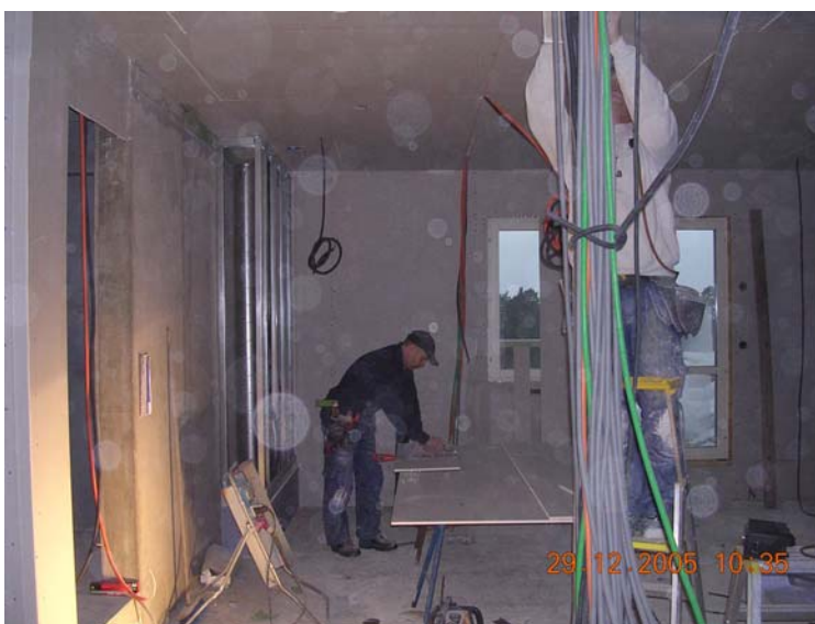
Bild 18. Uppsättning av gipsskivor som innerväggar.
