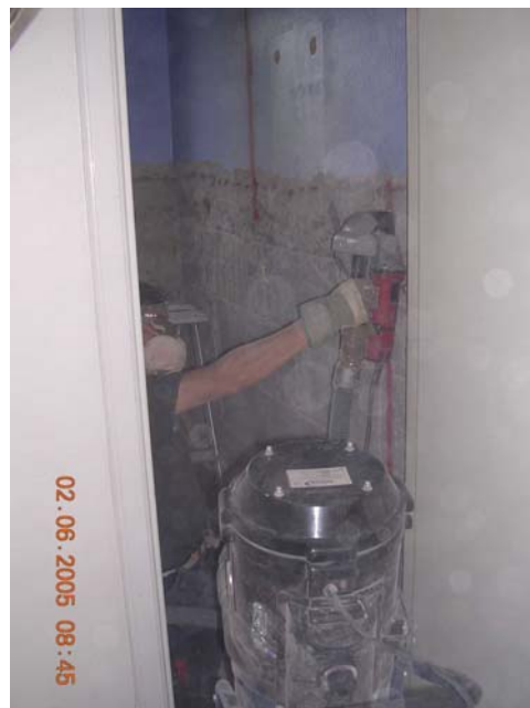
Bild 10. Fräsning är ett arbetsmoment som kan undvikas. Här används en industridammsugare som var mycket dåligt underhållen. Dessutom användes inte P3-filter i andningsskyddet, vilket innebar att exponeringen kan bli hög, eftersom skyddsåtgärderna är undermåliga.
