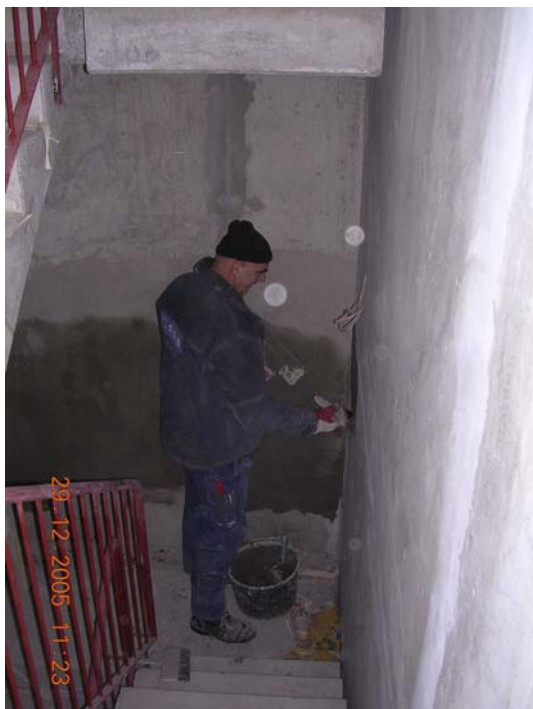
Bild 22. Spacklar igen små hål i väggen innan väggen ska slipas och målas.
