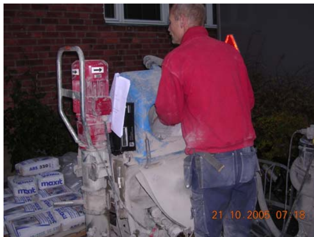
Bild 17 ovan. Påfyllning av säckar vid automatisk blandning av flytspackel.
