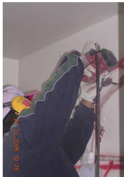
Bild 12. För att ta bort materialet mellan spårerna används en mejselhammare.
