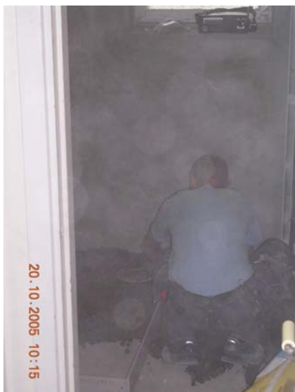
Bild 30. De säckar som just lyfts in genom fönstret sprids ut i badrummet för att fylla upp golvet. Mätinstrumentet står i fönsterkarmen ca 1 m ovanför personen.
