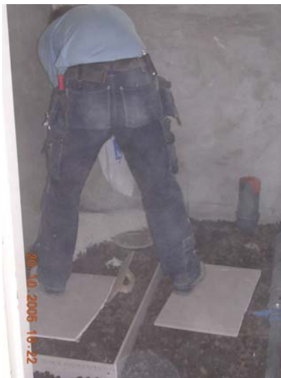
Bild 15 Ovanpå leca-kulorna läggs ett lager marmorkross.
