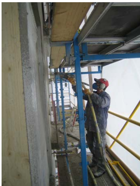
Bild 25. Personen som sprutar ut putsen har ett enklare andningsskydd.
