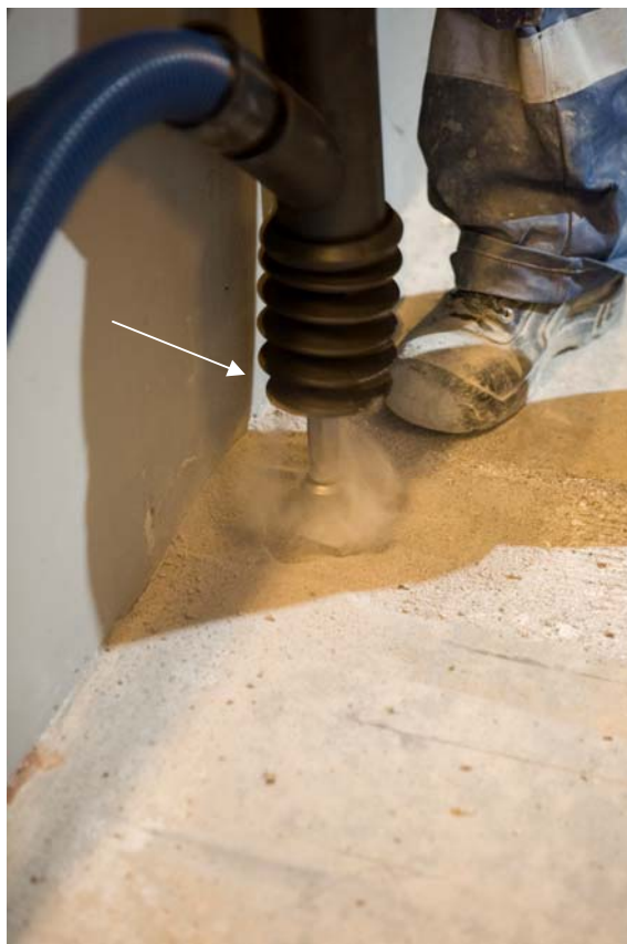
Bild 4 och 5. Utsug till bilningsmaskin. Bilderna är tagna av Dustcontrol, som också tillverkar utsuget.
