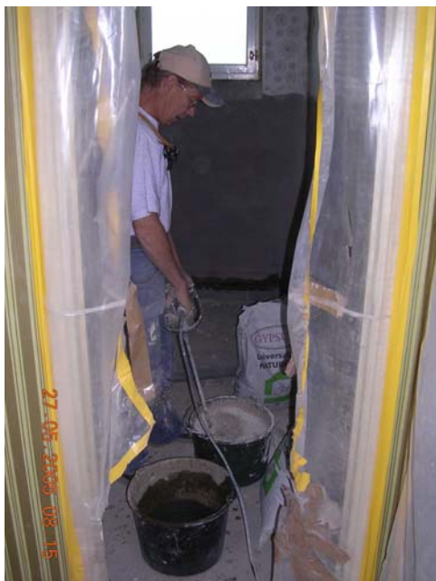
Bild 17 ovan. Påfyllning av säckar vid automatisk blandning av flytspackel.
