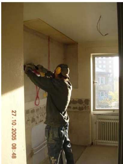
Bild 11. Elektrikern har sprayat på väggen där man vill att elledningarna ska dras. Fräsning görs med spårfräs med två spår
